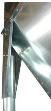
Stütze verschraubt
